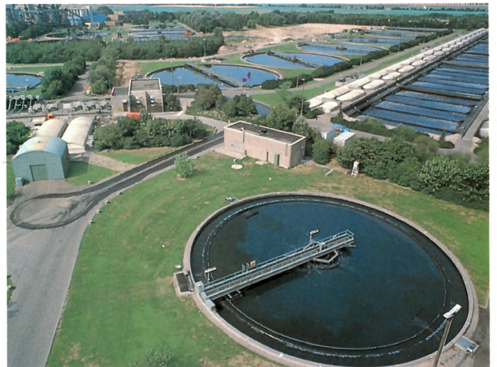
Kläranlage Ludwigshafen. Grobentschlammfänger. Im Hintergrund rechts Belebungsbecken, links davon Nachklärbecken.
